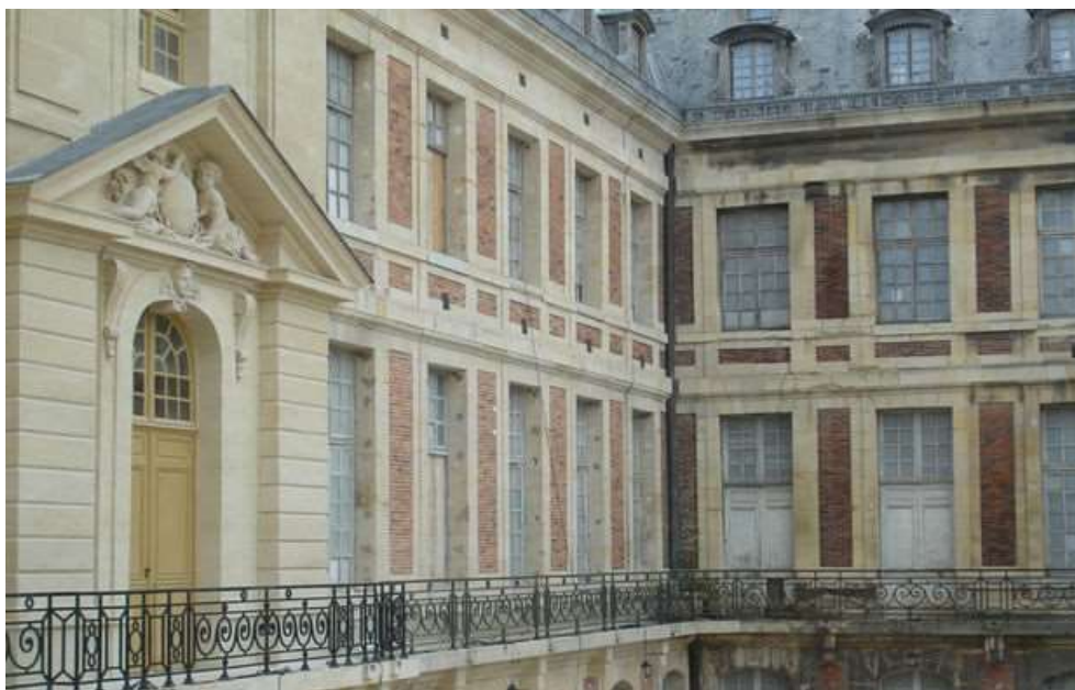
Image de la restauration architecturale du Grand Commun au château de Versailles (Yvelines) - © Milena Chessa / Le Moniteur.fr
