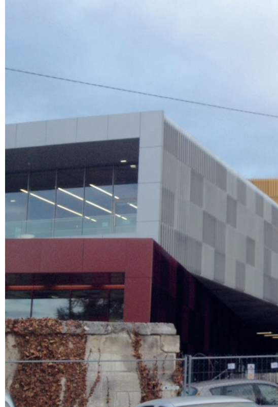
« Porte-à-faux » du bâtiment.
