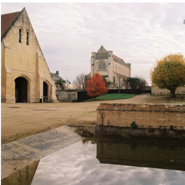
L'abbaye d'Ardenne, dans le Calvados, tout juste rénovée à l'époque, a été choisie en 2004 pour accueillir les fonds de l'Institut.
