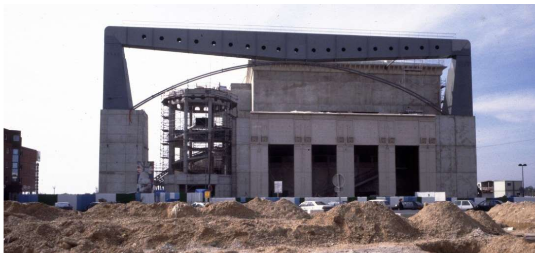
Le TSQY en construction au début des années 1990
