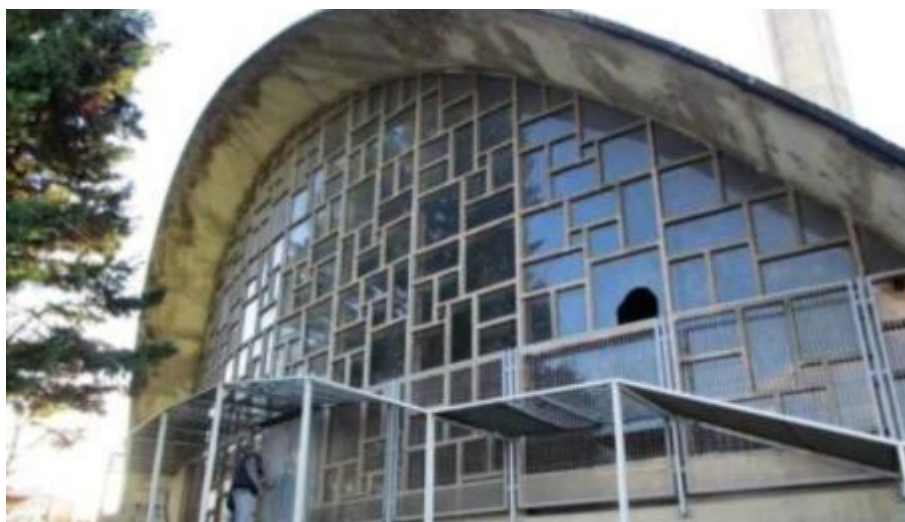
A l'intérieur de la chaufferie des L'ancienne chaufferie des Tarterêts, en 2014. DRAC Ile-de-France, CRMH, photographie Xavière Desternes
