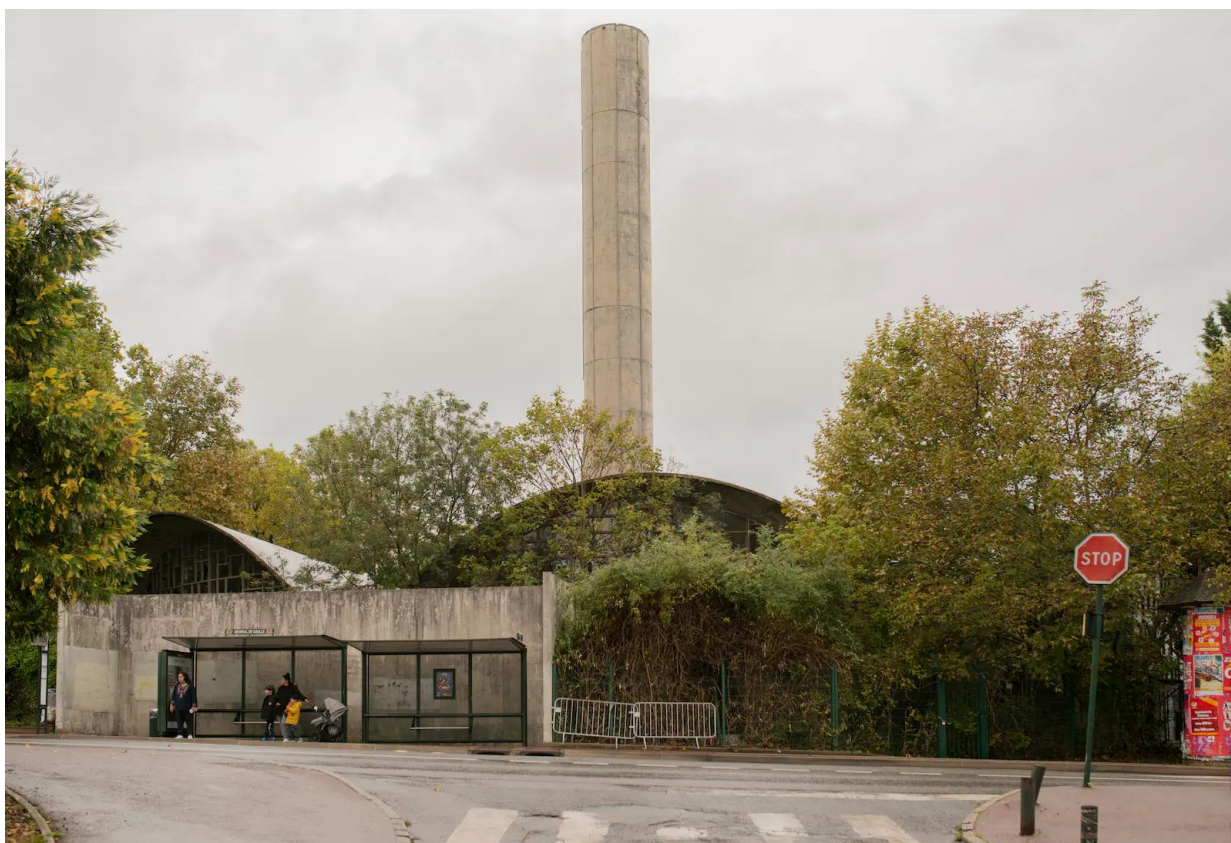
La chaufferie de Corbeil-Essonnes dans le quartier des Tarterêts, le 17 octobre 2024. (Christophe Maout/Libération)
